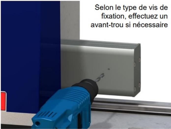
Selon le type de vis de fixation, effectuez un avant-trou si nécessaire
